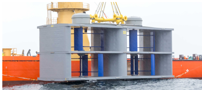
Figure 1. Démonstrateur de l'hydrolienne marine de Hydroquest lors de son installation sur le site d'essai de Paimpol-Bréhat
